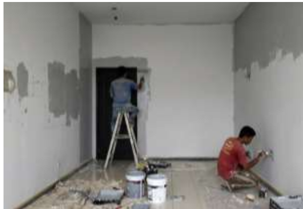
Gambar 6. Proses renovasi retail UMKM Batik di Gayungan (Dokumentasi Pribadi, 2026)
