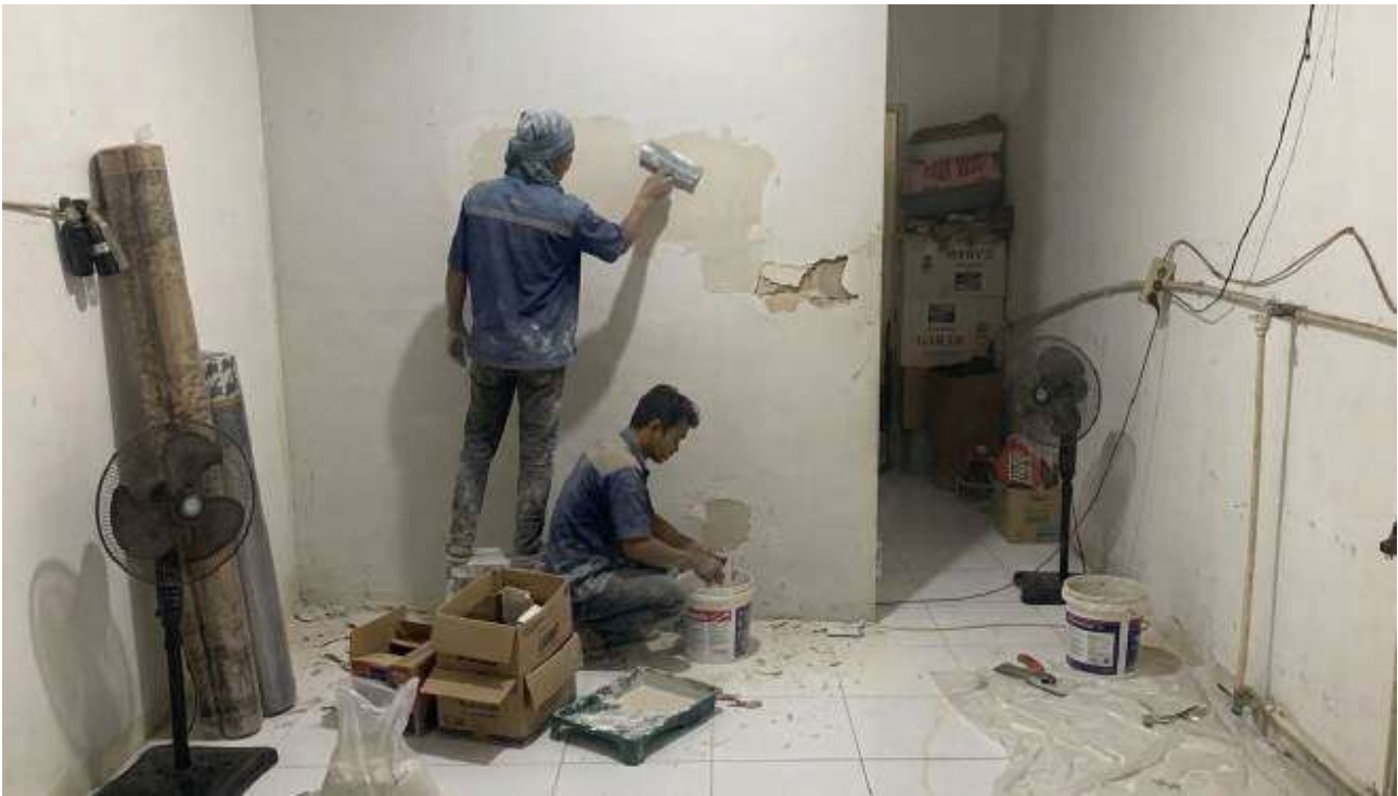
Gambar 1.8 Proses renovasi Umma Laundry (Dokumentasi Pribadi, 2026)
